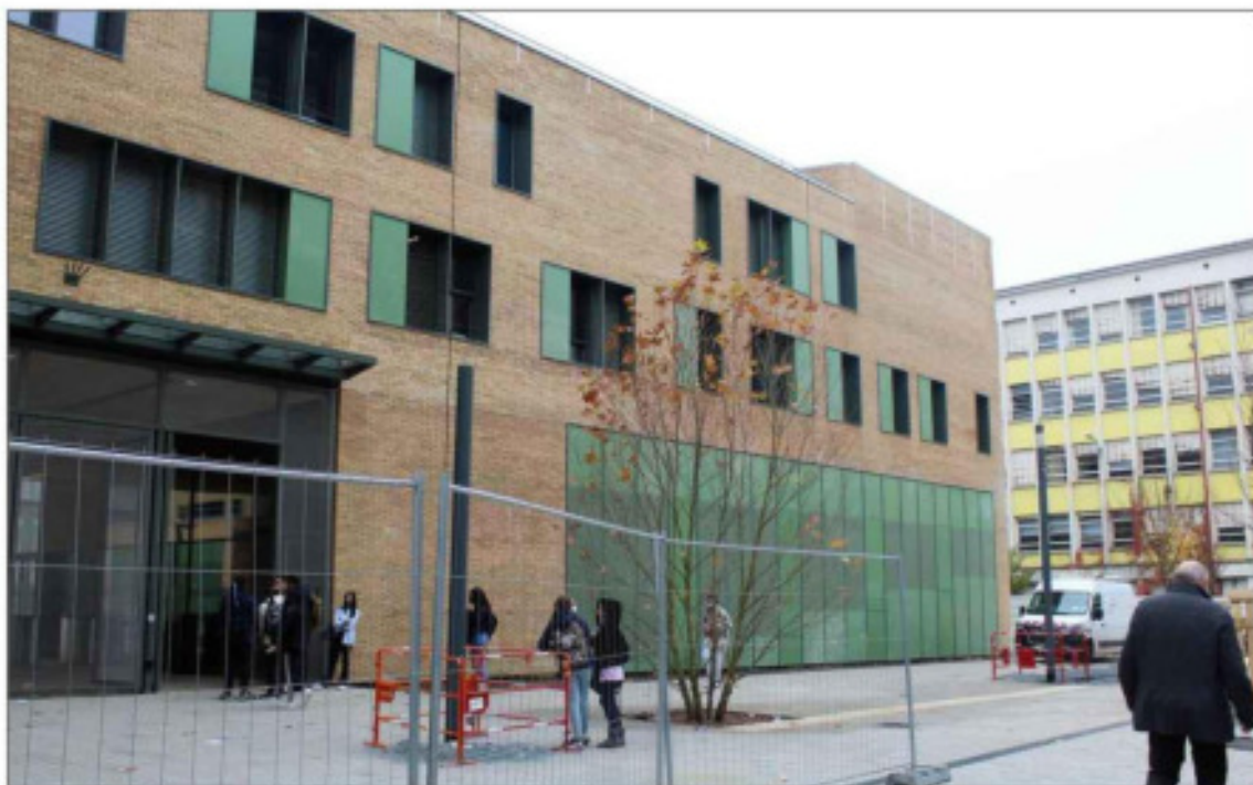
Au premier plan, le nouveau lycée Brossolette. Au second plan, l'ancien bâtiment destiné à la démolition. Photo Progrès/Solen WACKENHEIM
